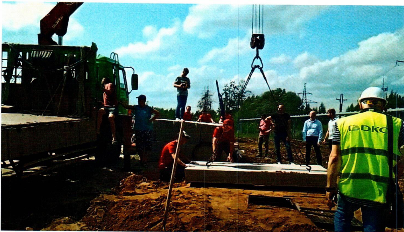
Фото 6 – Установка плиты дорожной с отверстием для люка диаметром 0,6 м ПД-6
