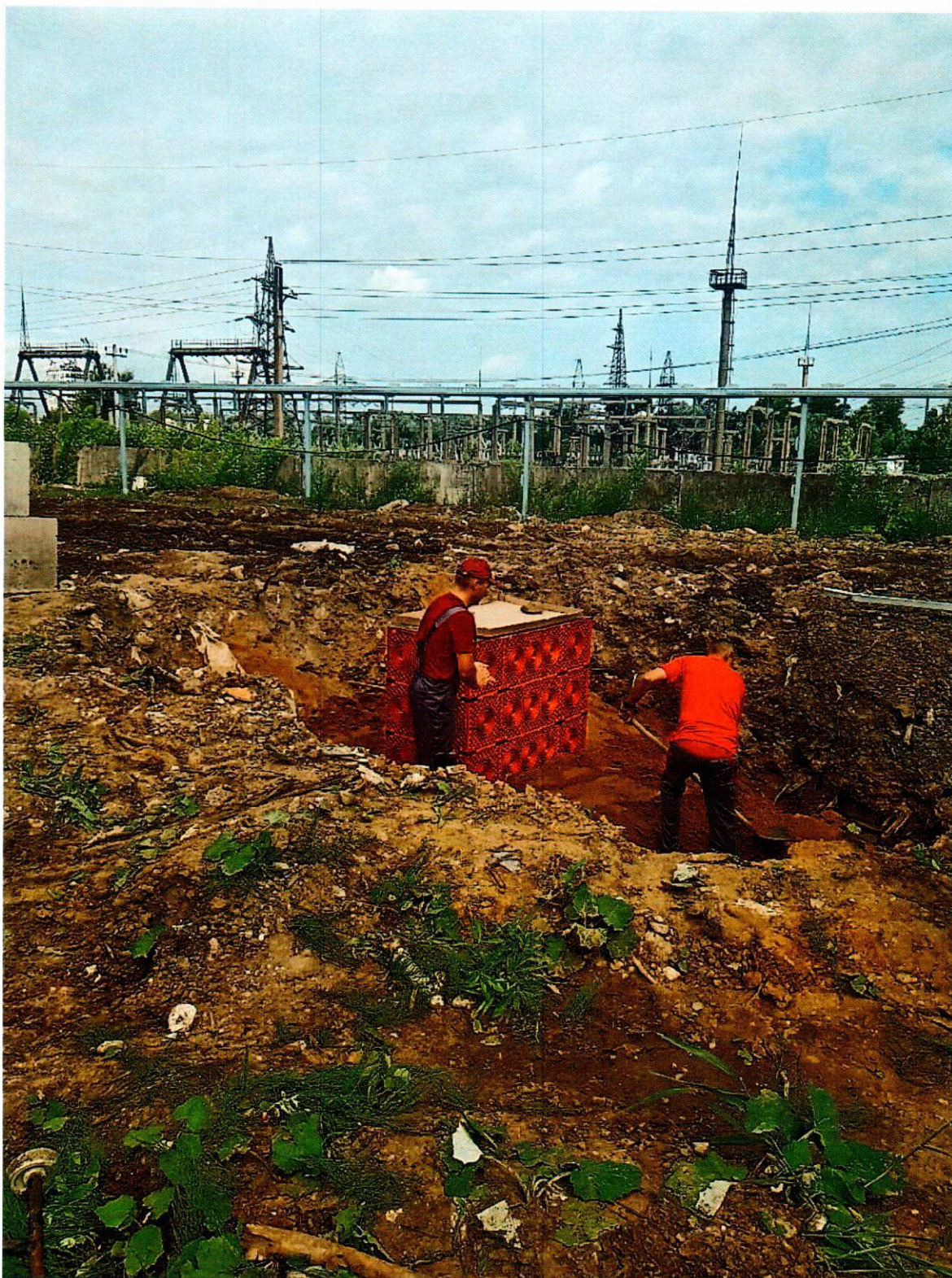
Фото 3 – Обратная засыпка котлована после установки колодца с послойным уплотнением
