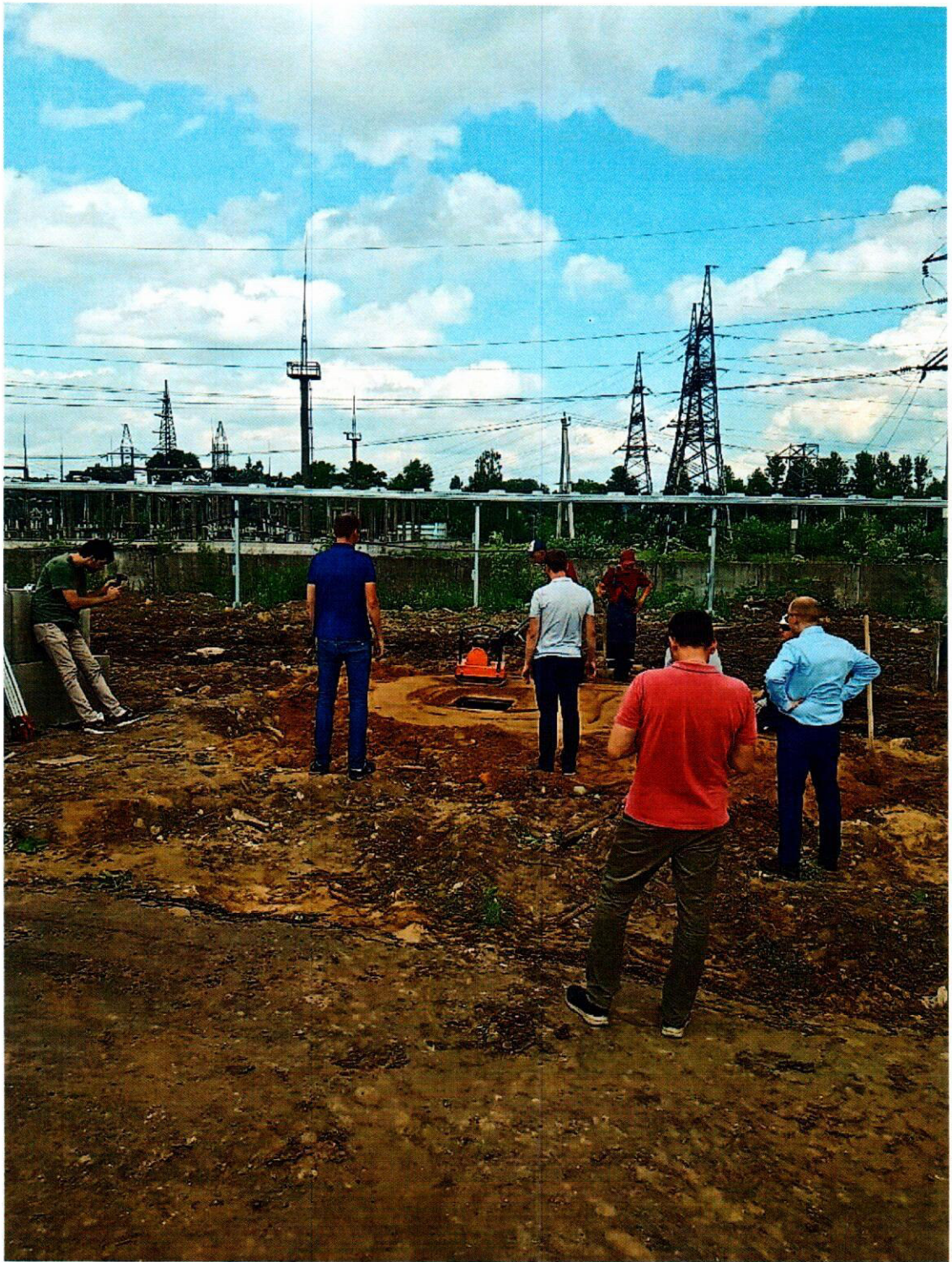
Фото 4 - Уплотнение верхнего слоя при обратной засыпке котлована
