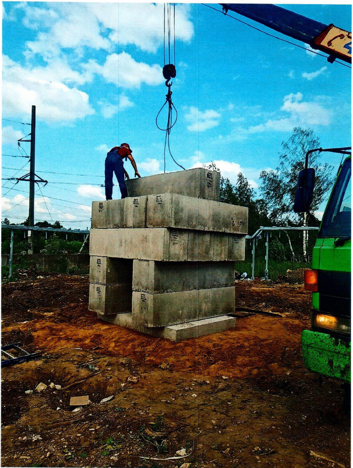
Фото 8 – Первый этап испытаний – нагружение до нагрузки 25 тонн
