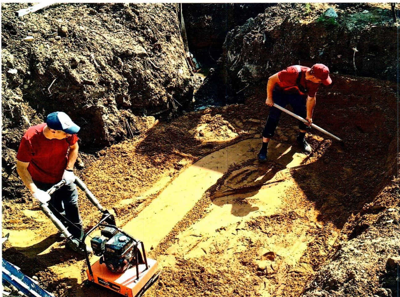
Фото 1 – Подготовка основания под колодец
