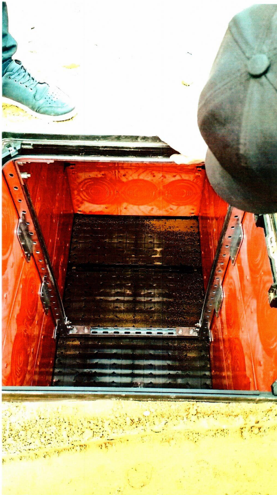
Фото 5 – Вид колодца изнутри после обратной засыпки
