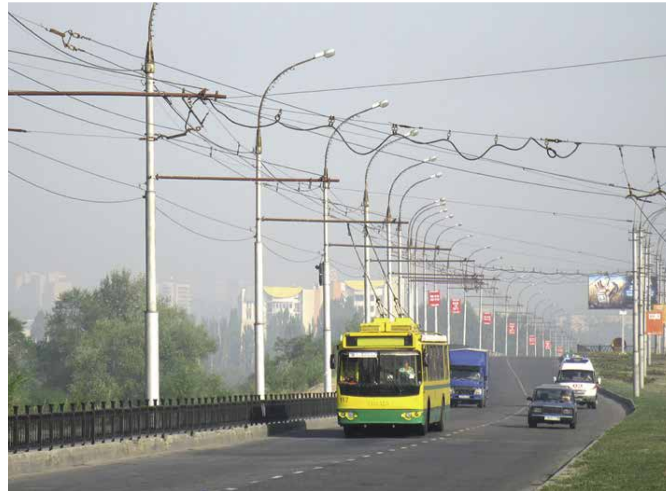
г. Липецк, Петровский мост
