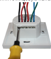
Рис. 2. Подключение проводов.
